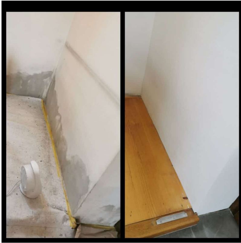
Vorher / nachher Bestandteile der Mischung des Verputzes wird mit Mikro Camera Analysiert und gemessen, anschließend von Hand gemischt Bestandteile: Kalk, Sand, Gips und Pflanzliche Cellulose.
