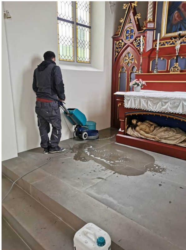
Durch die Reinigung des Sandstein Bodens mit der Einscheibenmaschine werden Tiefe Verschmutzungen aus dem Boden gereinigt, mit Antiwax Classic hellt der Boden zum ursprüngliche Farbton auf.
