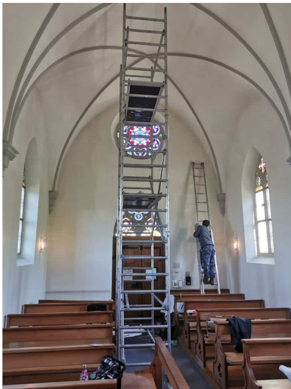
Die gesamte Raumschale wird mit Latex- Gummis trocken freigelegt. Das Gewölbe ist in einem sehr guten Zustand. Die Außenwände sind stärker verschmutzt durch die entstehende Kältebrücke.
