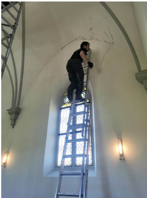
Risse werden keilförmig geöffnet und mit artgerechtem Material an bestehende Oberflächen angepasst. Anschließend mit Keim Athenit Lucente örtlich dünn lasiert.
