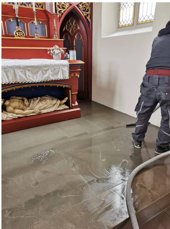
Boden Reinigung mit dem Wasserstaubsauger wird das Verschmutzte Wasser aufgesaugt.
