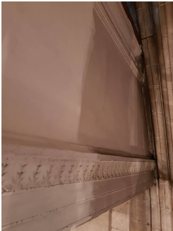
Trockenfreilegung am Stuck bei der Emporen Brüstung
