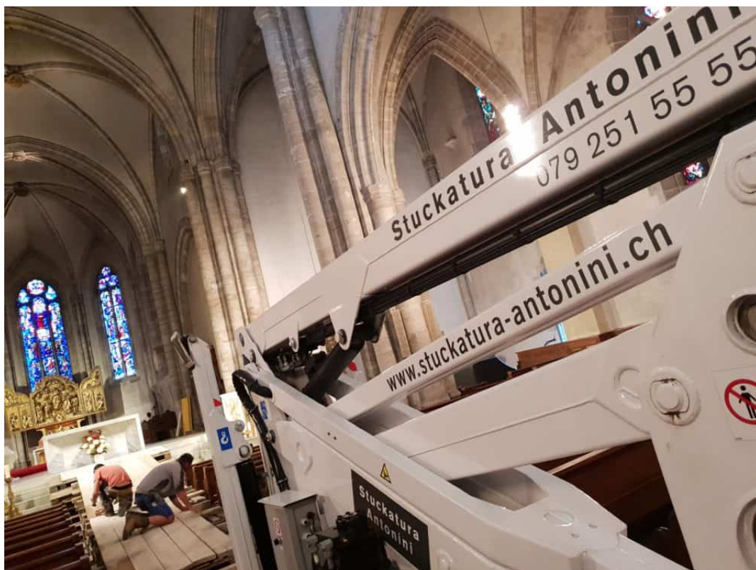
Aufbau der Rampen zum Chorhaus.
