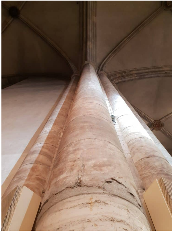
Verschmutzung der Stein Säulen.
