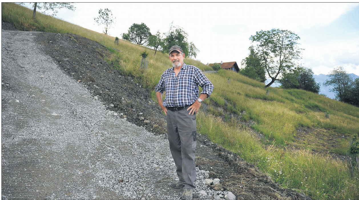
Immer wieder musste Josef von Moos die Strasse zu seiner Liegenschaft (hinten) in Stand stellen. Nun soll von der anderen Richtung her eine neue Strasse entstehen. Bild Corinne Glanzmann
